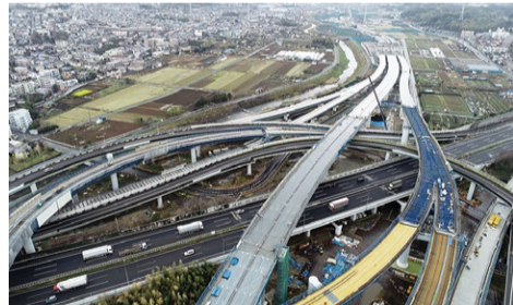
横浜環状北西線 (横浜青葉インターチェンジ・ジャンクション付近)▶
