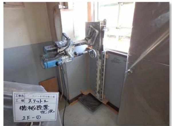
スリット削孔中の様子
