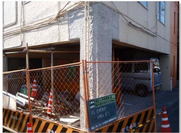
鉄筋コンクリート増打ち部と既存部分が一体となるように表面の目荒しを行う
