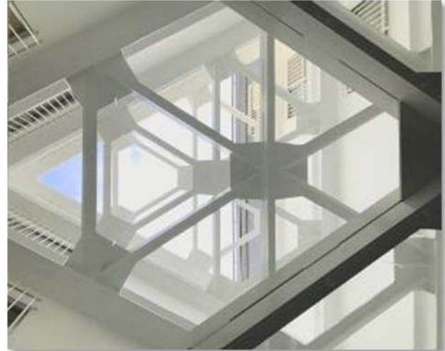
鉄骨水平ブレース補強を見上げた様子
