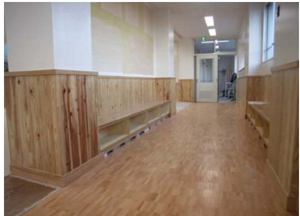
写真6-8 横浜市 さわの里小学校（廊下）
