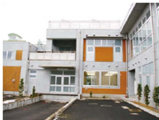
写真7-8 左側の外壁は軒の出があり塗料の落ち無し（卓越風の風下に当たる。）
