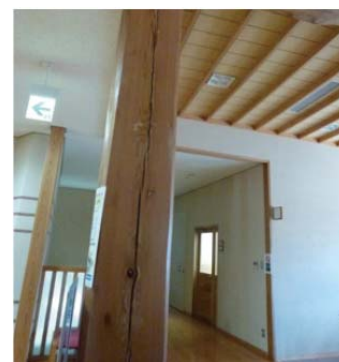
写真7-12 柱の割れ
