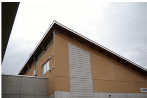
写真7-10 片流れ屋根棟部
