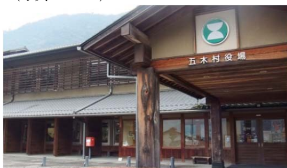
写真7-13 ポーチ独立屋根の柱
