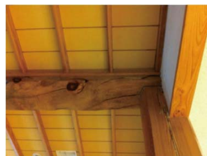
写真7-11 ねじれ対策の補修
