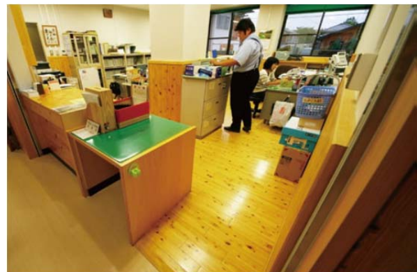
写真7-16 集成材の床 (都幾川公民館事務室)
