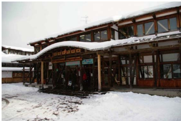
写真 7-2 正面玄関の隅柱
