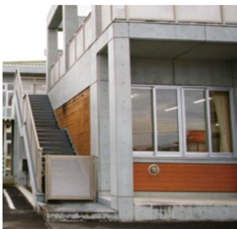
写真7-7 北西外壁に隣接する庇下の外壁は塗料の落ちはない
