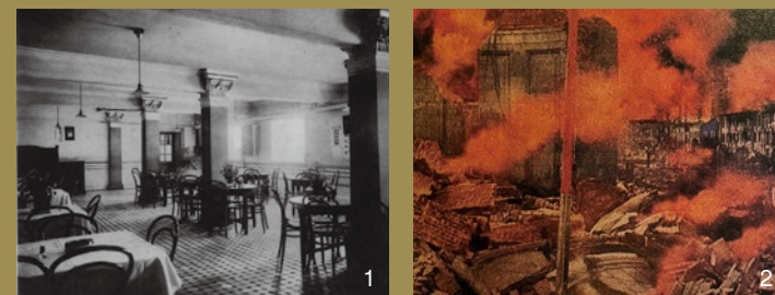
1:1917 本町食堂（横浜市社会事業施設一覧）開港記念会館地下に食堂があった。「本市ノ中心地ナル関内ニハ各種ノ官公署及び内外商店軒ヲ並べ、之ニ通勤スル官公吏商店員ハ甚ダ多数ニ上ルノデアル。（中略）記念会館ノ地下室ヲ利用シテ公設ノ簡易食堂ヲ開設スルコトナッタノデアル。」/2:1923 開港記念横浜会館（横浜開港資料館所蔵）周辺は被災し瓦礫となっているが、右側奥に時計塔がそびえ立っている。
