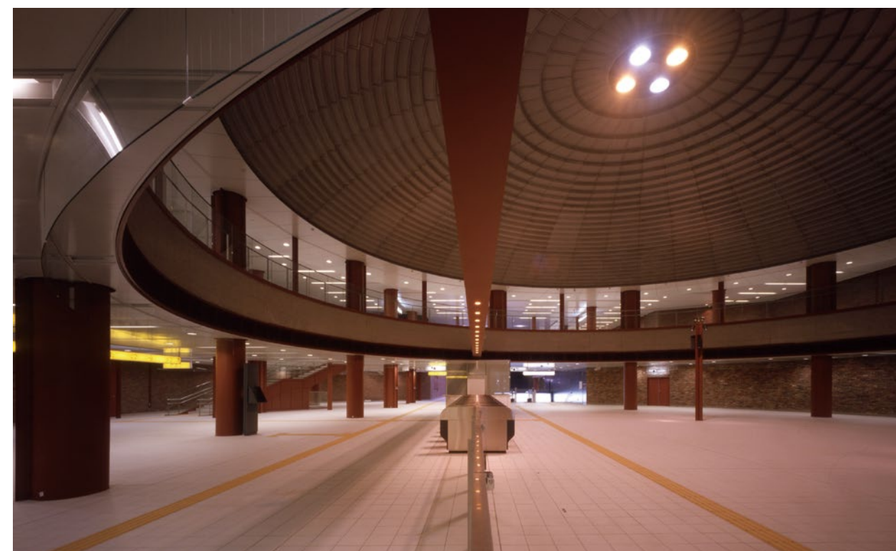
みなとみらい線馬車道駅(内藤廣建築設計事務所提供)
