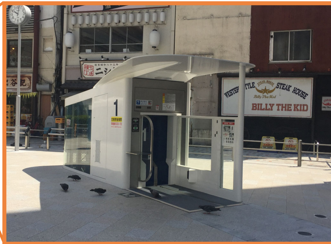
地上入出庫口（地上構造物）
