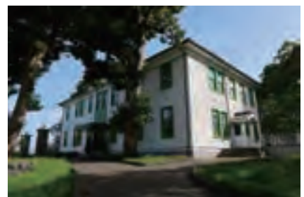
長浜ホール（旧事務所棟）
