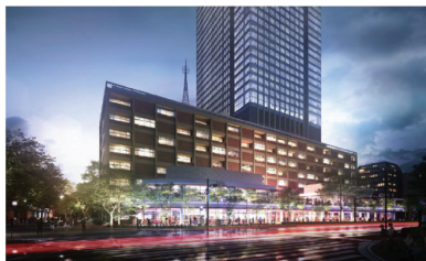
旧市庁舎街区活用事業のイメージ (イメージ図:三井不動産㈱ニュースリリース)
