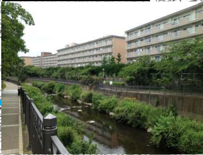
④南小菅ヶ谷住宅
