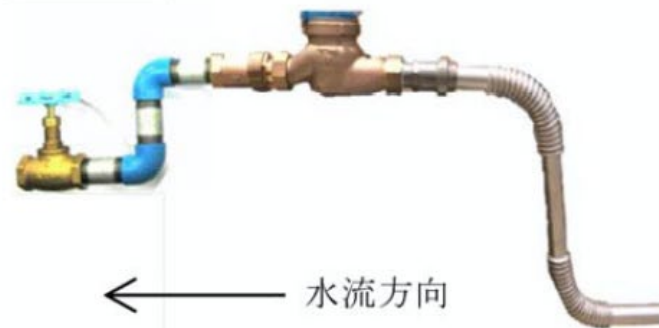
(イ) 呼び径 40 の配管例
