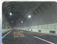
シールド工法で建設されたトンネル(山手トンネル)
