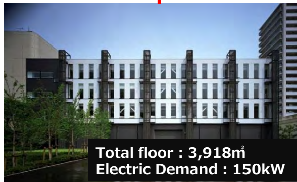
TAK Shinsuna Bldg.
