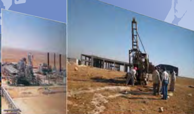
◎ 日揮株式会社 (アルジェリア/ガス処理プロジェクト) ◎ 株式会社オオスミ (シリア/CDMプロジェクト調査協力)
