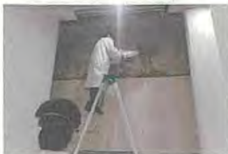
専門会社による地下1階パネル裏消毒
