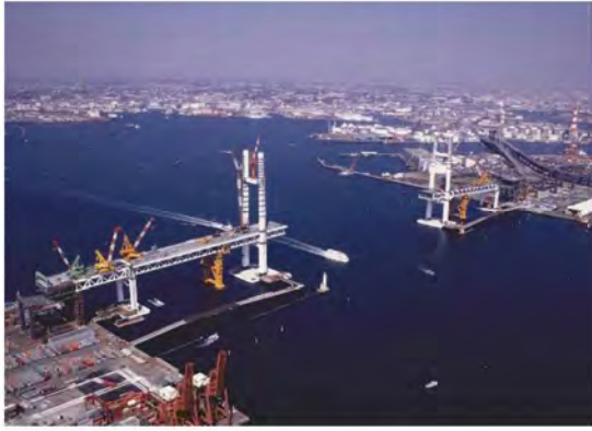
建設工事中の横浜ベイブリッジ 昭和63年(1988年)
