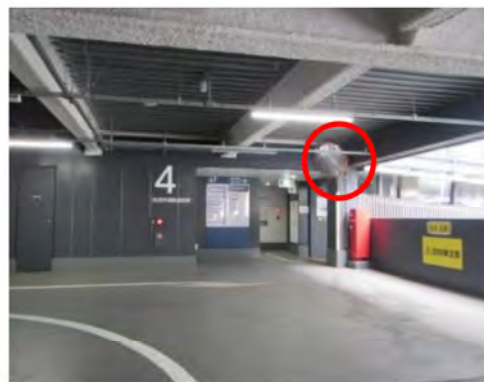
(施工後 カーブミラーにより死角の解消)
