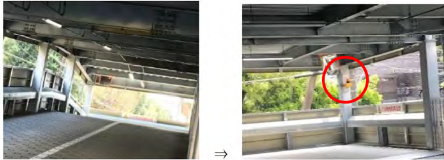
(コーナー部分への回転灯設置による注意喚起の実施)
