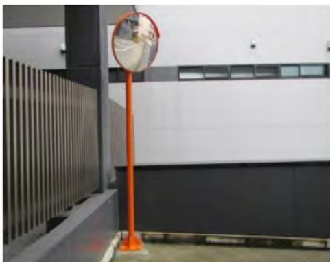
(施工後 カーブミラーにより死角の解消)
