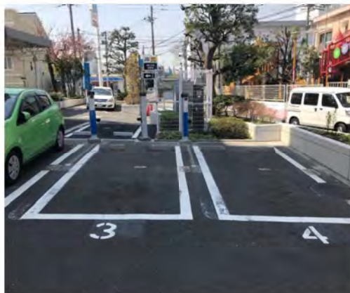
（フラップレス式による利用しやすい駐車場の整備例 西区庁舎駐車場）
