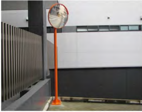
(施工後 カーブミラー設置により死角の解消)
