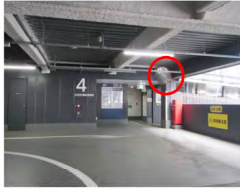
(施工後 カーブミラー設置により死角の解消)
