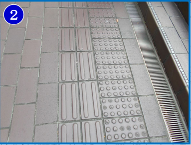
【横浜市中央図書館】 ●視覚障害者誘導用ブロックの視認性の改善
