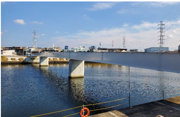
右岸から左岸方向を望む(全景) (令和7年2月撮影)
