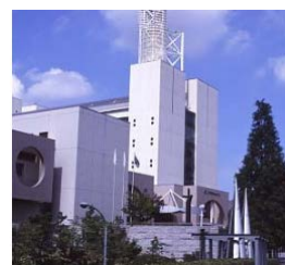
LED 化を進める都筑区総合庁舎
