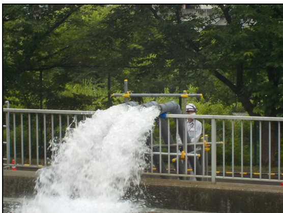
可搬型自吸式ポンプによる排水訓練（令和4年度）
