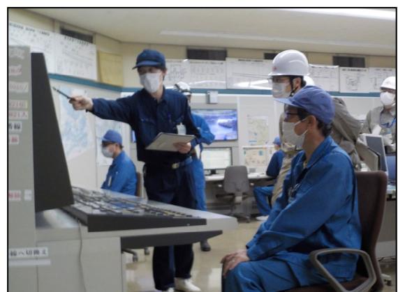
設備の手動運転訓練（令和4年度）
