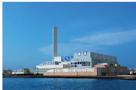
資源循環局金沢工場外観
