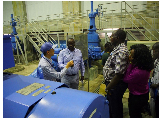
機械設備維持管理・点検の視察の様子 （令和3年）
