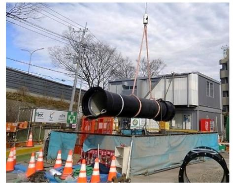
口径800mm配水管布設替工事
