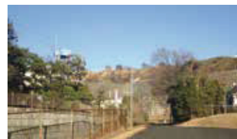
【地区西側の斜面地】
