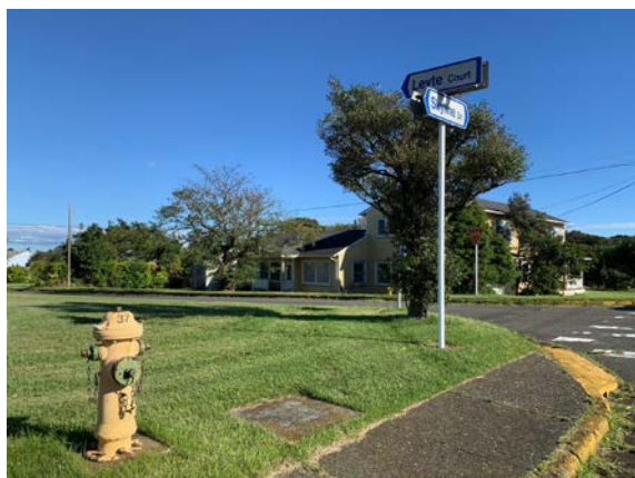
消火栓と標識
