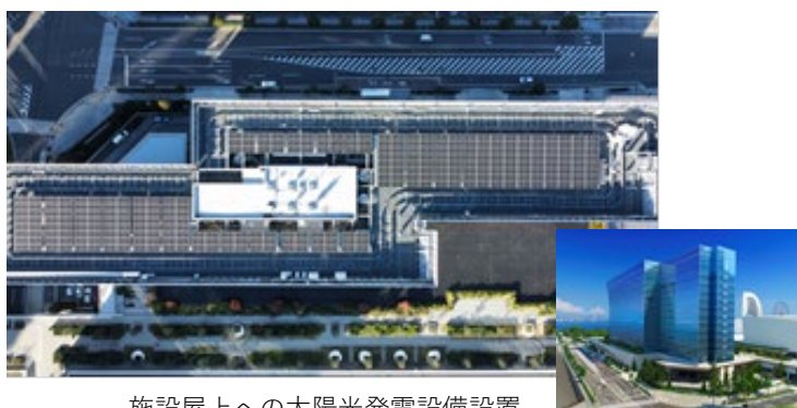
施設屋上への太陽光発電設備設置
