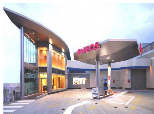
ENEOS 横浜綱島水素ステーション
