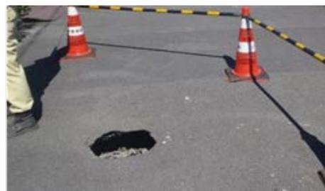
Zパイプ破損による道路陥没
