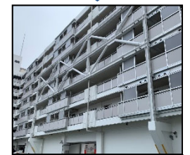
耐震改修補助金利用例
