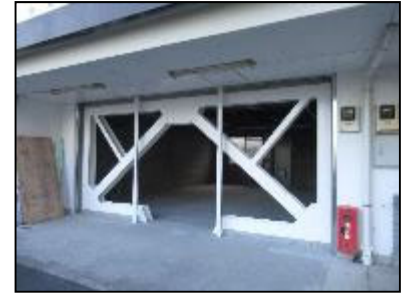
マンションの1階ピロティ部分に耐震ブレースを新設した事例
