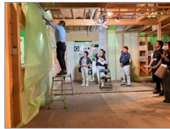
断熱・気密施工の実技講習会
