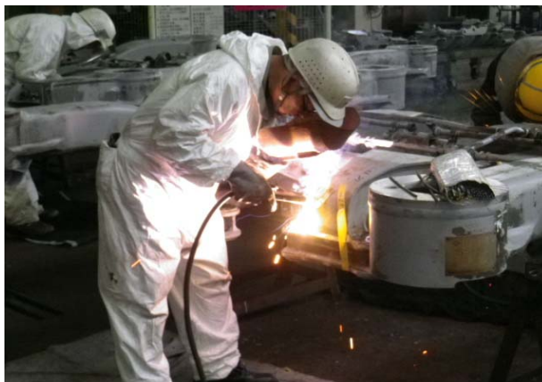
製造メーカーによる修繕作業
