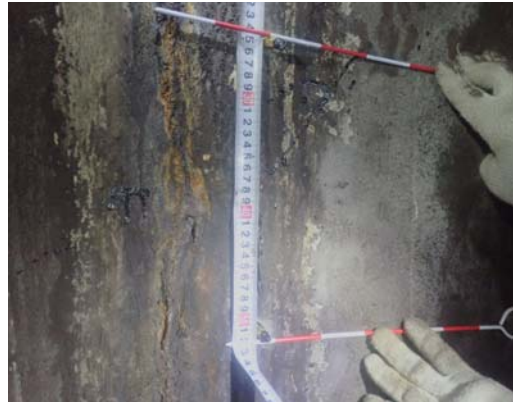
止水注入状況
