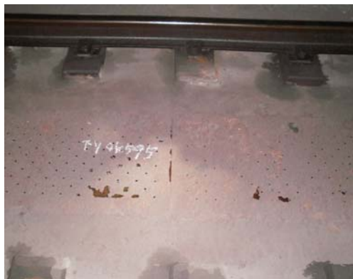
排水溝蓋(アンチスリップ鋼板)
