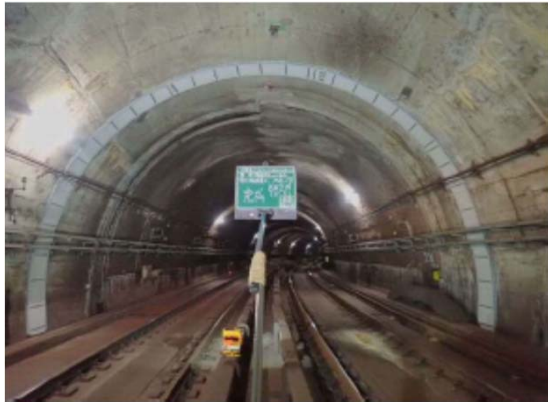
受け樋設置状況
