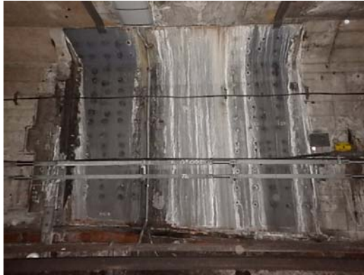
▲関内・長者町ケーソン耐震鋼板 下り
