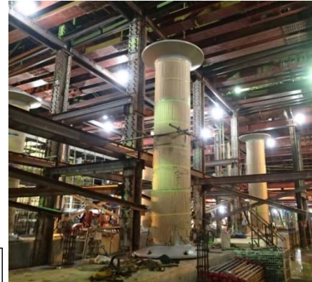
《工事現場の様子》
