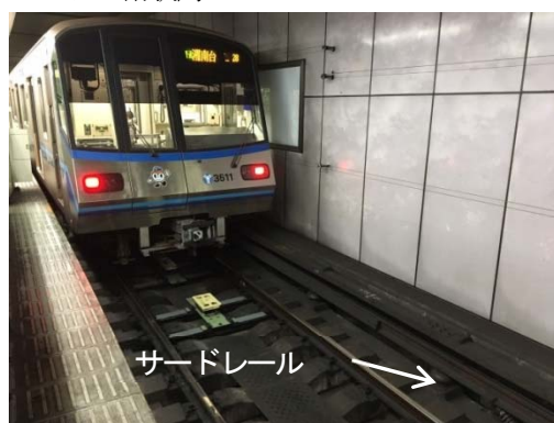
<サードレールの敷設写真>
