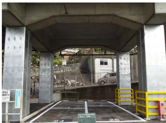
《ラーメン高架橋の橋脚の補強》
