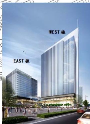
<53街区> (仮称) みなとみらい21中央地区53街区 開発事業者 共同事業体/代表企業 株式会社大林組 (令和5年度しゅん工予定)
