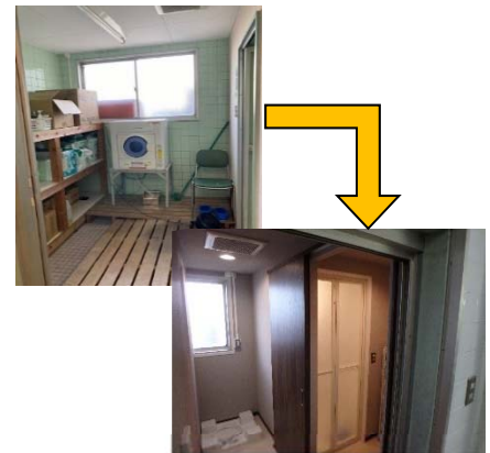
<執務環境改善（浴室改修）>
