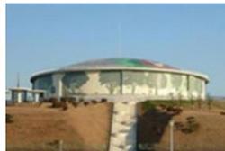
浄水場から出た水を貯留し、水の使用量に合わせて給水量を調整する施設で、市内に22か所あります。災害時には飲料水を確保します。
