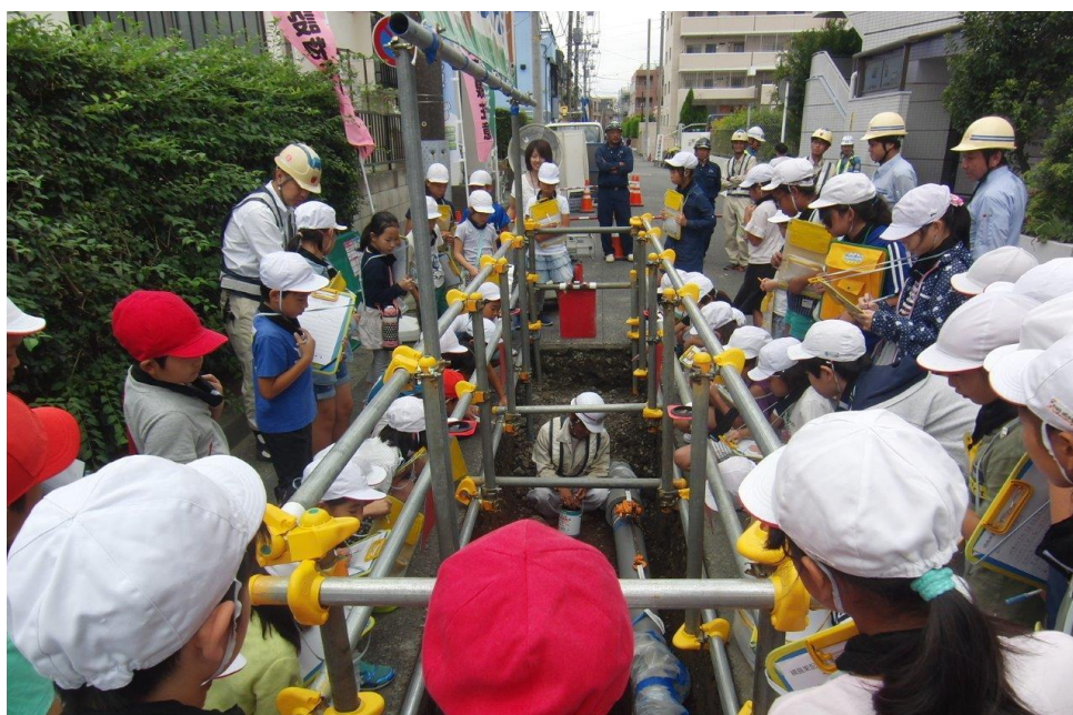
工事現場見学会
