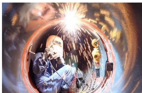
老朽管耐震更新工事（管内溶接）
