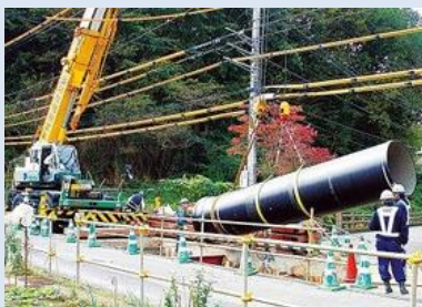
水道管の更新・耐震化工事
