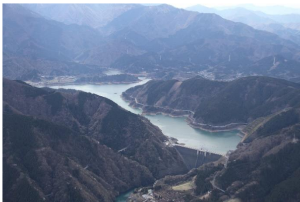
宮ヶ瀬ダム (平成 13 年完成)
