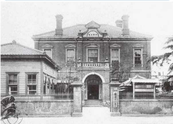
創設当時の横浜水道事務所
