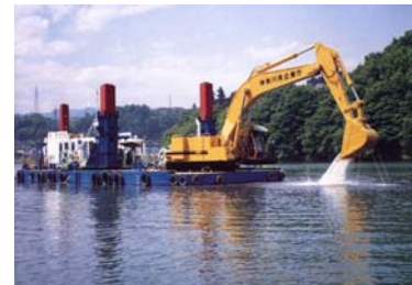
相模湖での土砂除去作業
