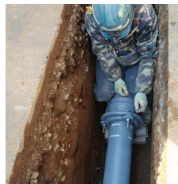
耐震管の布設状況
