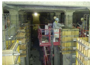
配水池の耐震化工事
