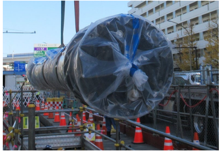
水道管の更新・耐震化
