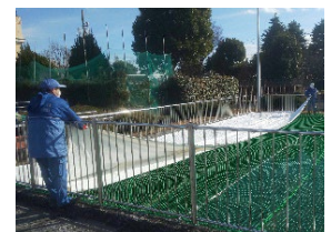
ろ過池をシートで覆い、火山灰の侵入を防ぐ対策
