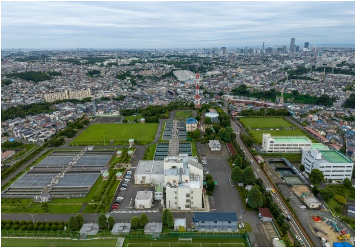
再整備を進める西谷浄水場
