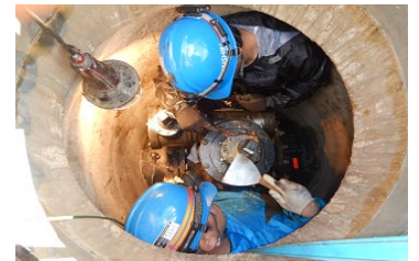
仕切弁点検調査の様子
