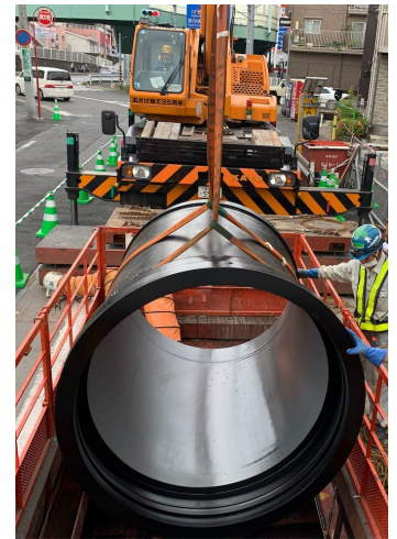
口径1350mm配水管更新工事
