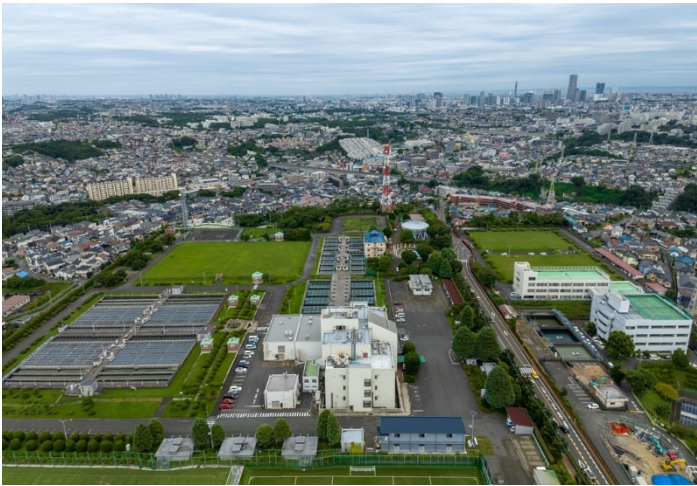
再整備を進める西谷浄水場
