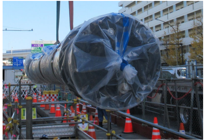
水道管の更新・耐震化
