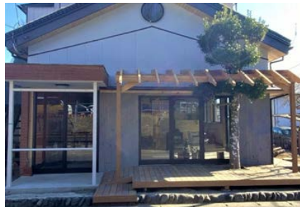
井戸や薪ストーブを設置し、いざという時に水と火を提供できる地域の交流拠点 「『水』と『火』のある地域のほっとステーション」 (緑区中山五丁目) ※令和4年2月開所
