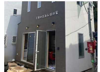
古い空き家を改修し、家族食堂やマルシェ等を行う多世代交流拠点 「子安台みんなの家」 (神奈川区子安台一丁目) ※令和4年5月開所
