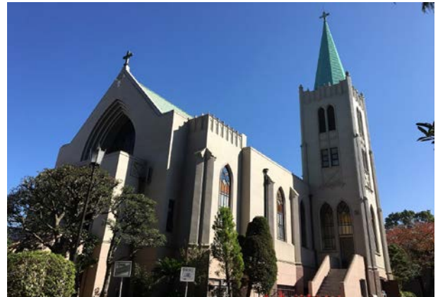
外観改修助成 山手カトリック教会聖堂(近代建築)
