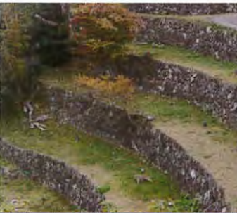
石積み護岸の縁石への利用-遺構A
