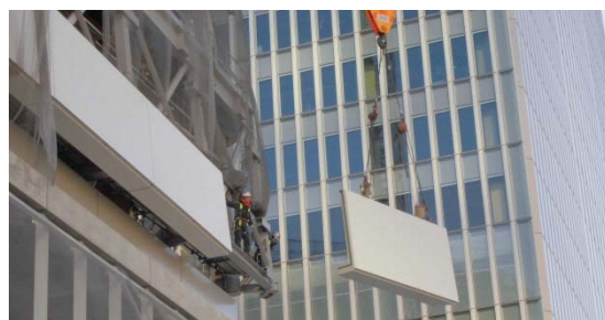
議会棟 外壁PC板取付
