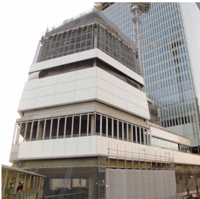
議会棟 外壁PC板
