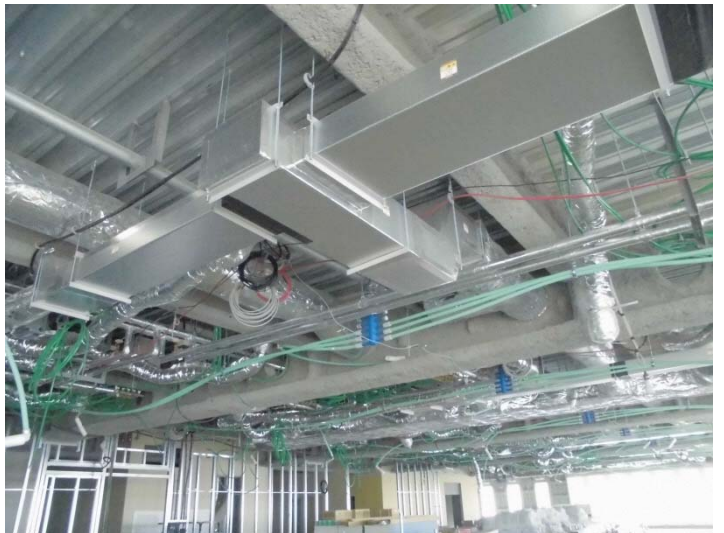
行政棟 設備配管・ダクト設置
