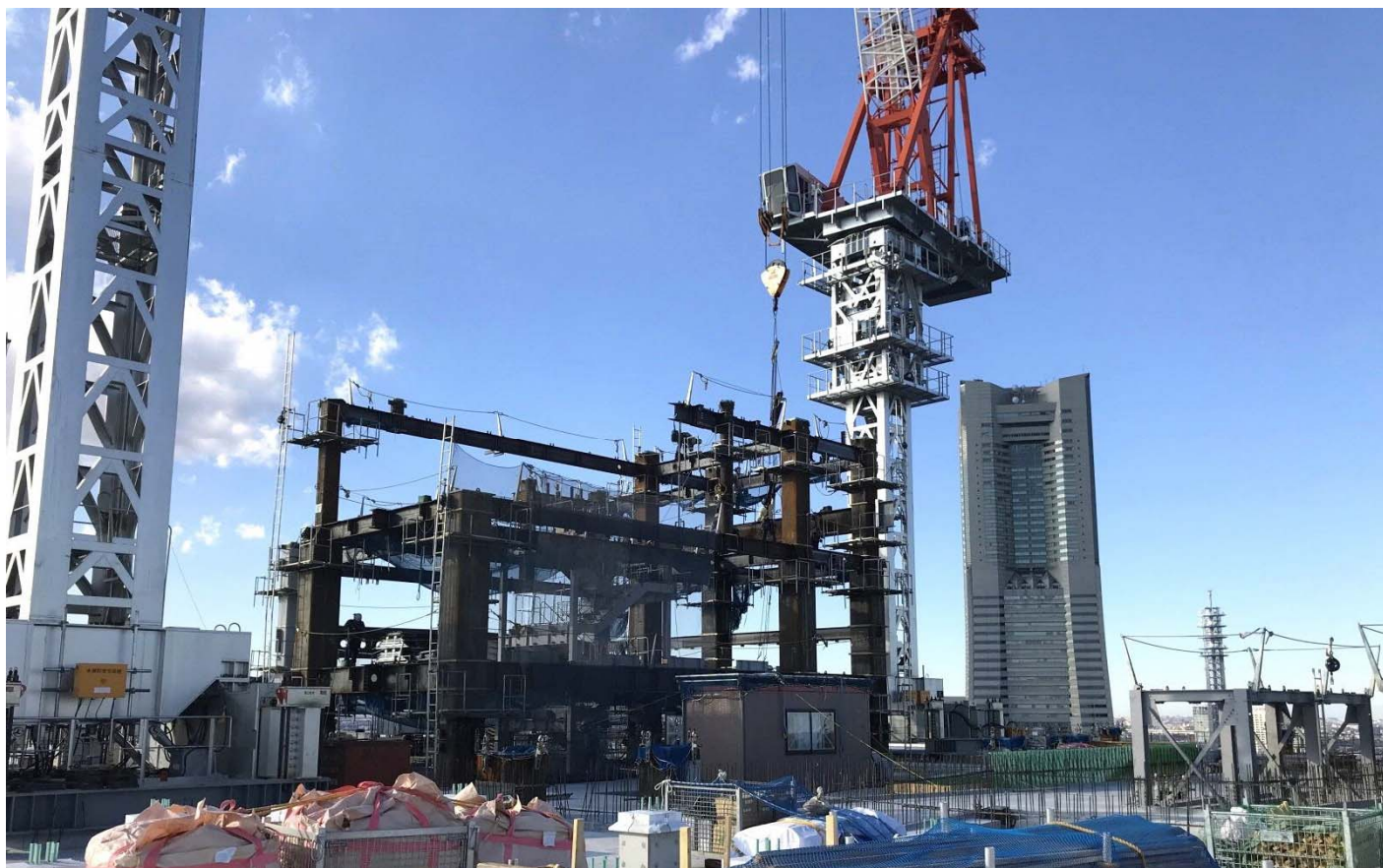
行政棟 塔屋鉄骨工事
