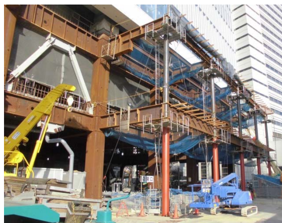
行政棟 低層部鉄骨建方
