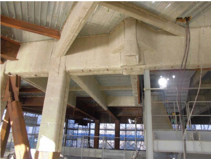
行政棟 鉄骨巻付け耐火被覆材
