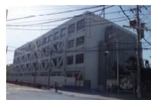
西区庁舎(耐震補強工事)
