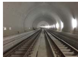
西谷トンネル
