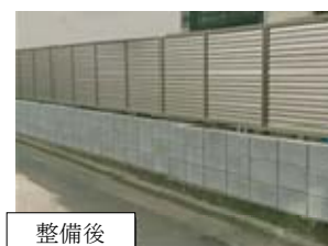
整備後 ブロック塀の改善
