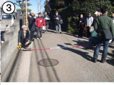
道路が狭く、車のすれ違い困難
