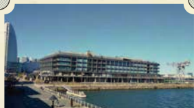
新港ふ頭客船ターミナル
