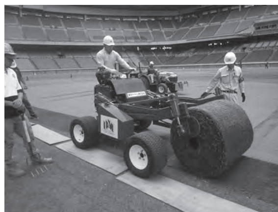
ハイブリッド芝敷設工事
