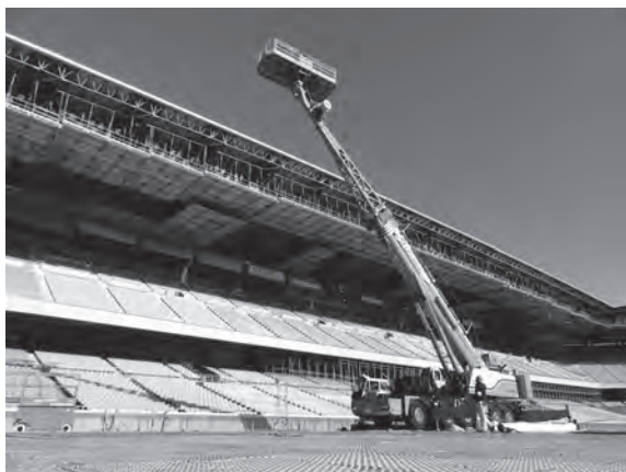
競技用照明LED化工事
